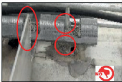
ILUSTRACIÓN 90: ANCLAJE DE ESTRUCTURAS AL TECHO
