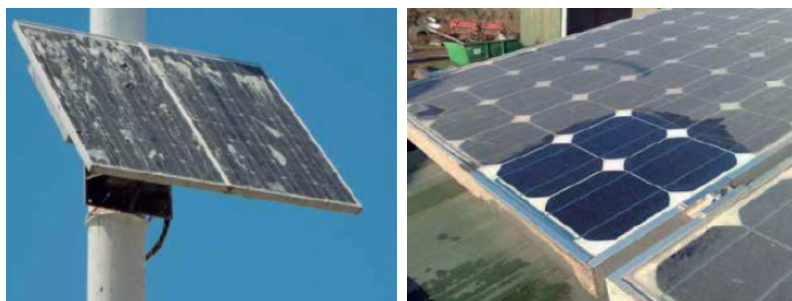
ILUSTRACIÓN 101: LIMPIEZA DE LOS PANELES SOLARES FOTOVOLTAICOS
