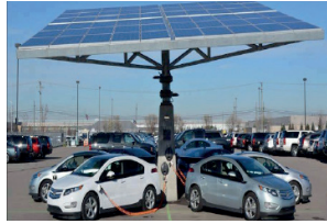
ILUSTRACIÓN 5: EJEMPLO DE UN SISTEMA SOLAR FOTOVOLTAICO, INSTALADO EN UN ESTACIONAMIENTO
