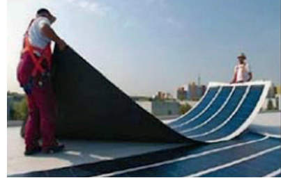
ILUSTRACIÓN 17: CELDA DE TECNOLOGÍA DE CAPA FINA
