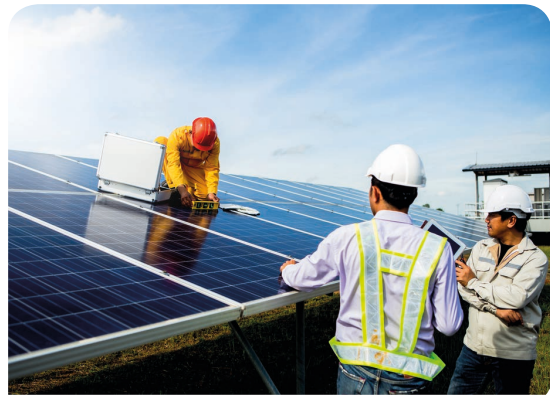
Instalación de paneles solares para producir energía solar.
