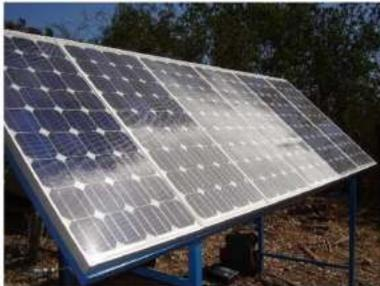
**Efecto Fotovoltaico:** generación directa de un voltaje eléctrico en la celda mediante la absorción de radiación solar
